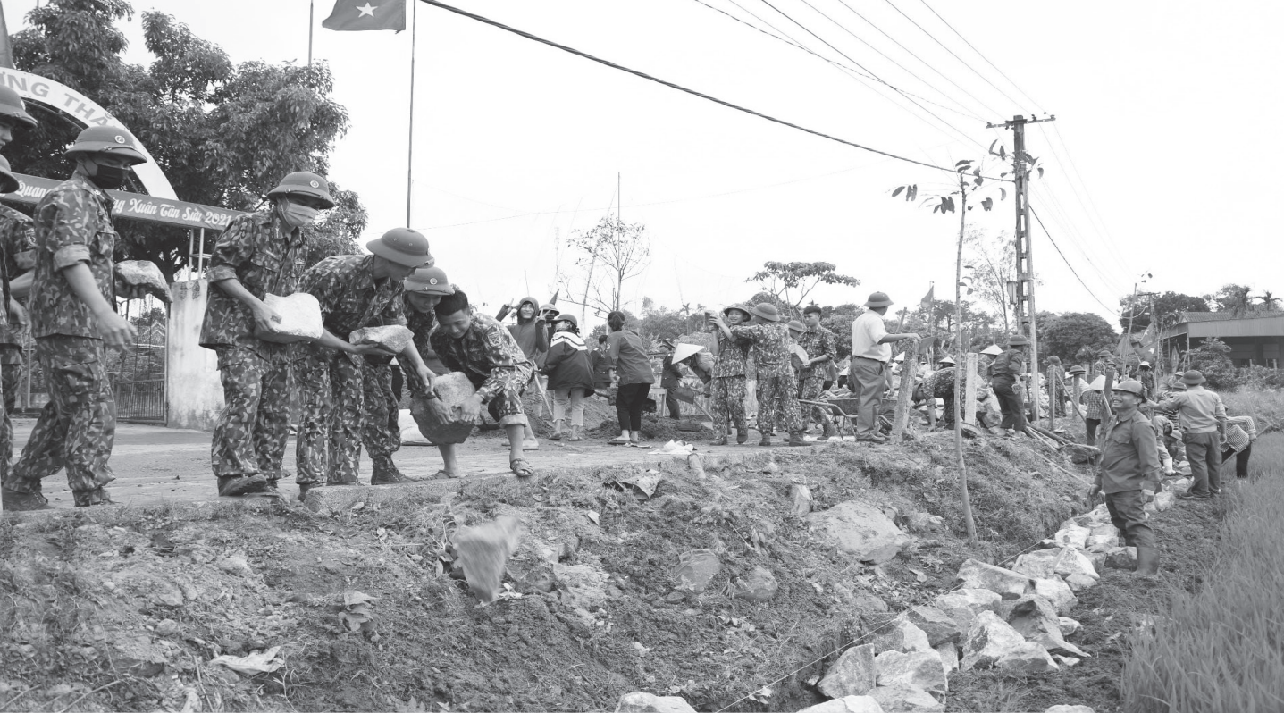
Bộ Chỉ huy Quân sự tỉnh giúp dân xây dựng giao thông nông thôn.
