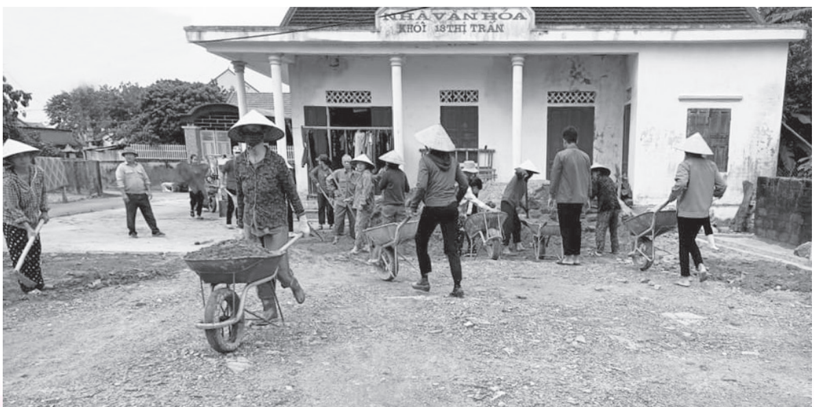
Tổ dân phố Đại Nghĩa nâng cấp lát gạch block sân nhà văn hóa
